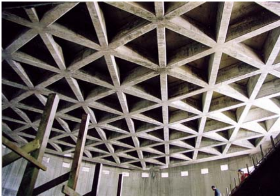
Firenze (FI), Polo universitario di Novoli, aula magna con solaio cassettonato, 2000
